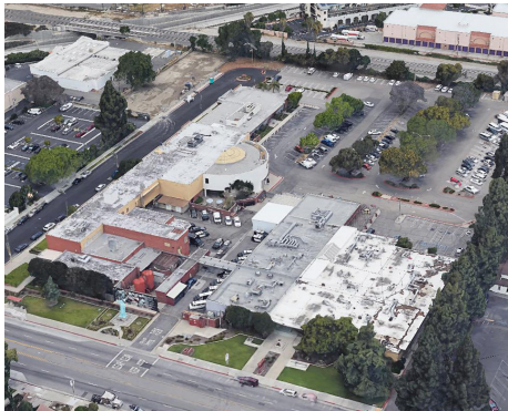
Existing Civic Center; El Monte, CA
