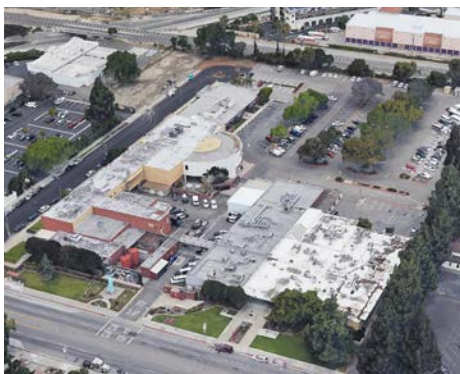
Existing Civic Center; El Monte, CA
